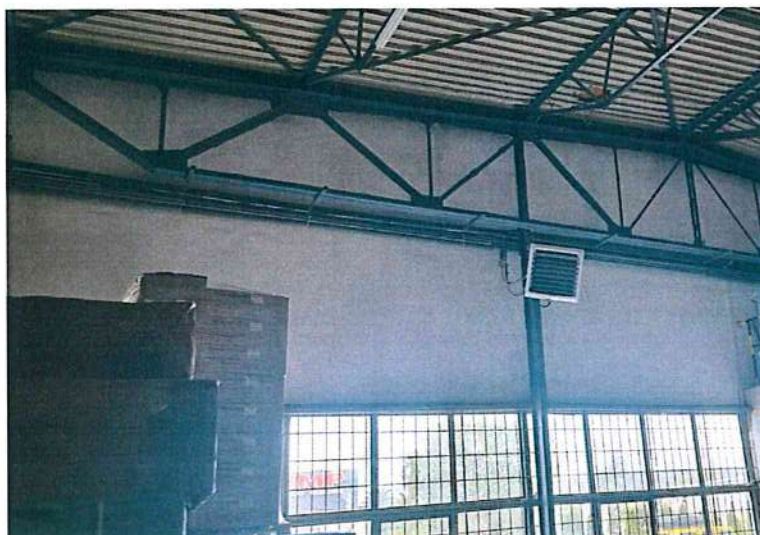
Fot.5 Kratownica stalowa
