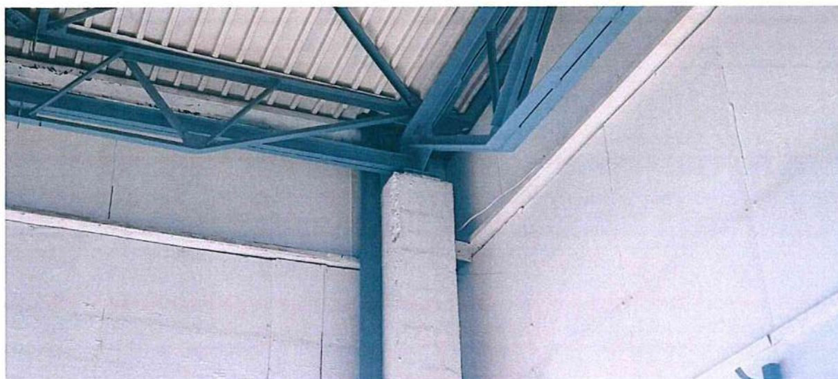
Fot.8 Odspojone płyty GK
