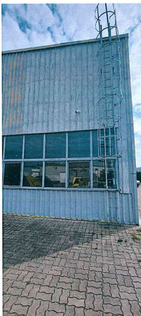
Fot.12 Drabina dachowa
