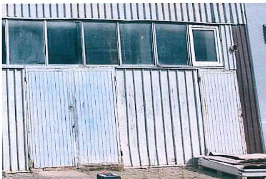
Fot.10 Pęknięcia oraz odkształcenia w stolarnie okiennej
