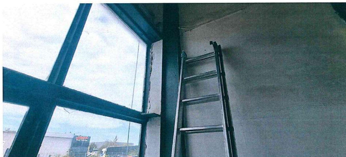
Fot.10 Pęknięcia oraz odkształcenia w stolarnie okiennej
